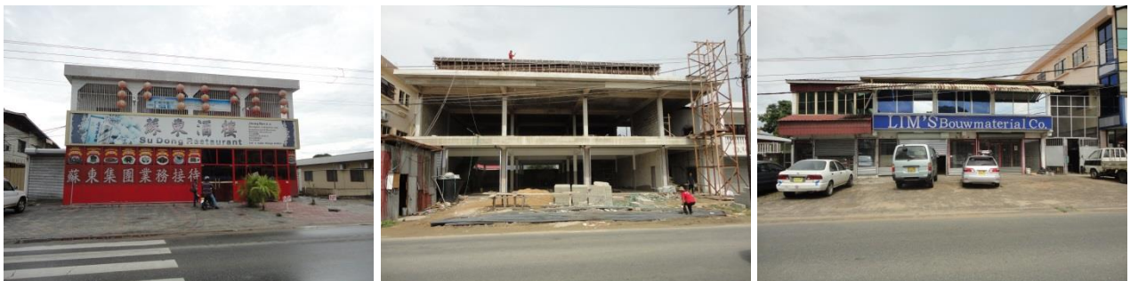
Figuur 12. Gompertstraat gevels, Paramaribo 2013
